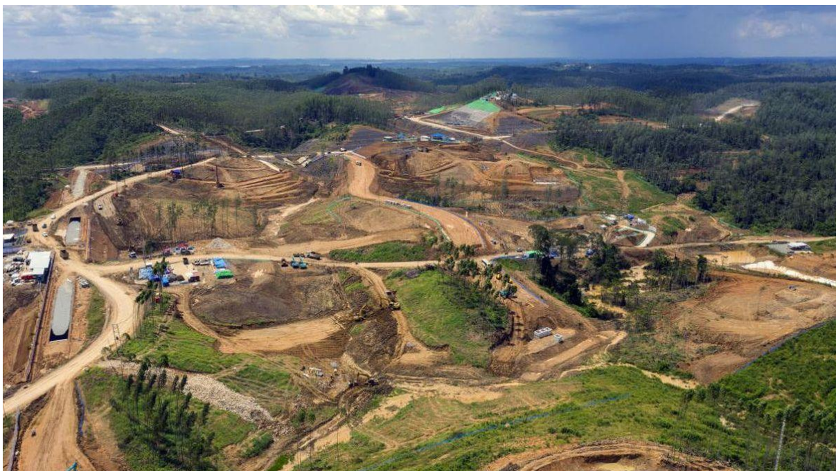
Gambar 1: Potensi kerusakan lingkungan dalam proyek IKN
